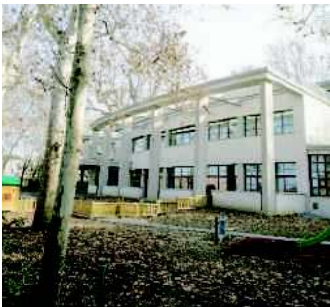
Le scuole Giaccaglia Betti appena ristrutturata alla Montagnola
